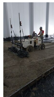
EXECUÇÃO DE PISO DE CONCRETO 02.jpg
