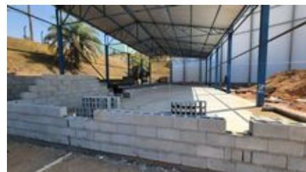
EXECUÇÃO DE ALVENARIA DE BLOCO.jpg
