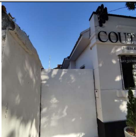
Foto 2: Em detalhe, fechamento da passagem junto a fachada lateral direita com a fachada frontal do imóvel, intervenção recente para a adequação comercial do imóvel. Alex Alves Pereira, 09 out. 2025.
