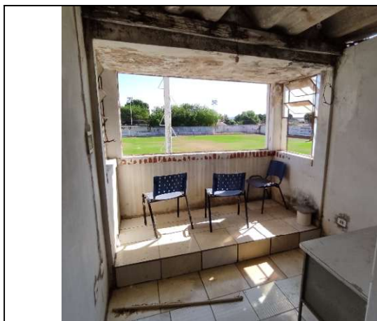
Foto 9: Vista geral para cabine de transmissão,laje, apresenta sinais expressivos de infiltração. Alex Alves Pereira, 09 out. 2025.
