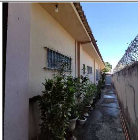
Foto 2: Vista da fachada lateral direita, com manchas de umidade ascendente no muro de divisa. Alex Alves Pereira, 09 out. 2025.
