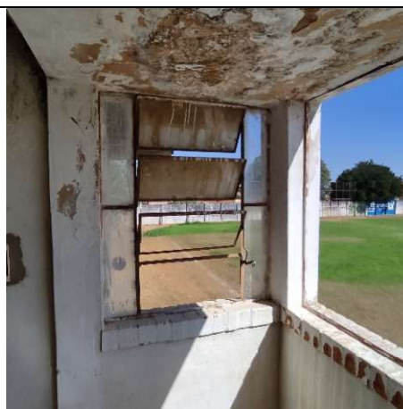
Foto 10: Esquadrias apresentam sinais de oxidação, sujidade acentuada e perda dos revestimentos em vidro. Alex Alves Pereira, 09 out. 2025.
