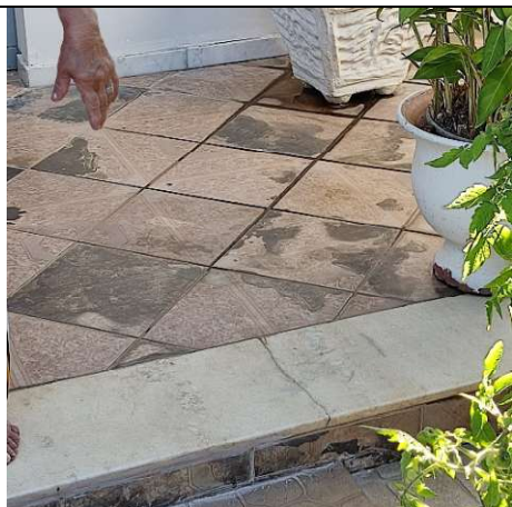
Foto 9: Em detalhe, manchas expressivas no piso externo da edificação. Alex Alves Pereira, 09 out. 2025.
