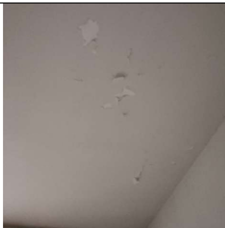
Foto 6: Em detalhe, descascamentos pontuais na pintura da laje interna. Alex Alves Pereira, 09 out. 2025.
