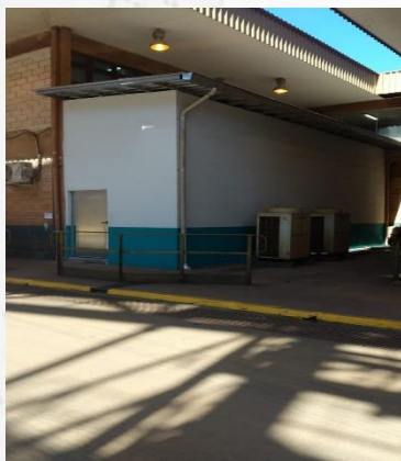
Ampliação Sala CCO - Mina Brucutu
