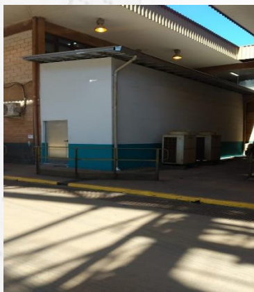
Ampliação Sala CCO - Mina Brucutu
