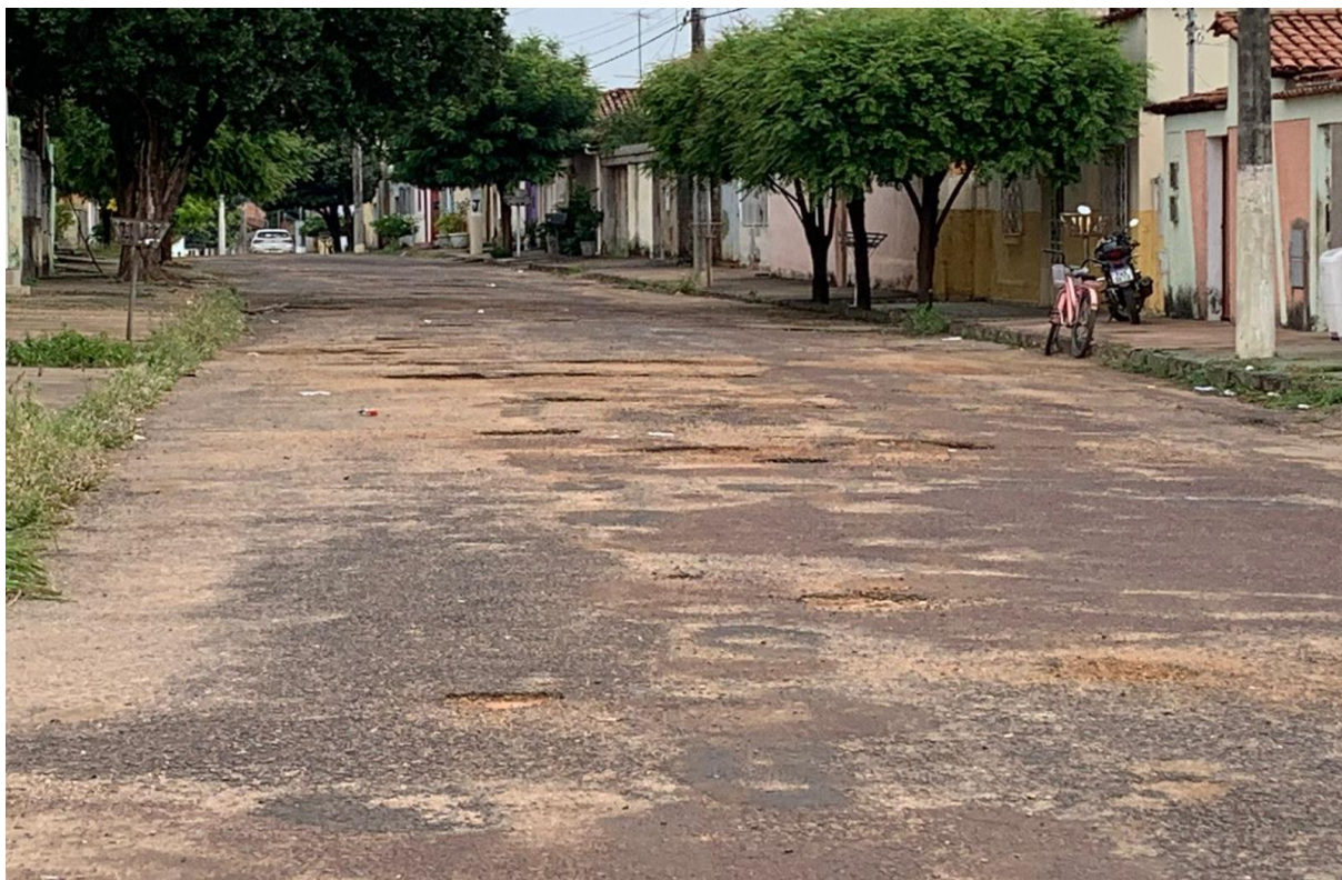
Rua Pará, Aparecida.
