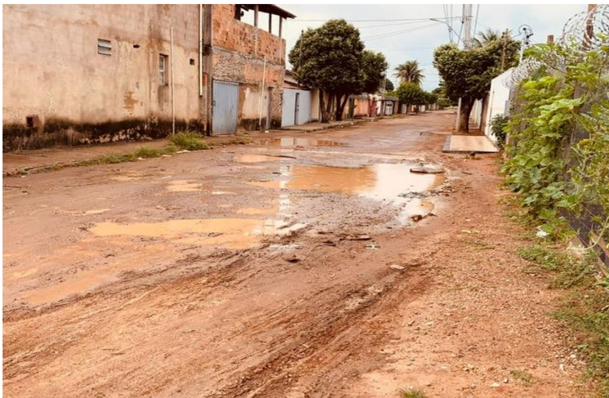
Rua A, Santa Terezinha.
