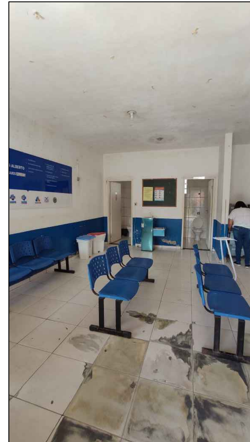
SALA DE ESPERA
