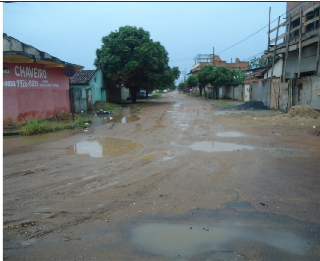
Foto 3: Tipo de obra: Pavimentação
