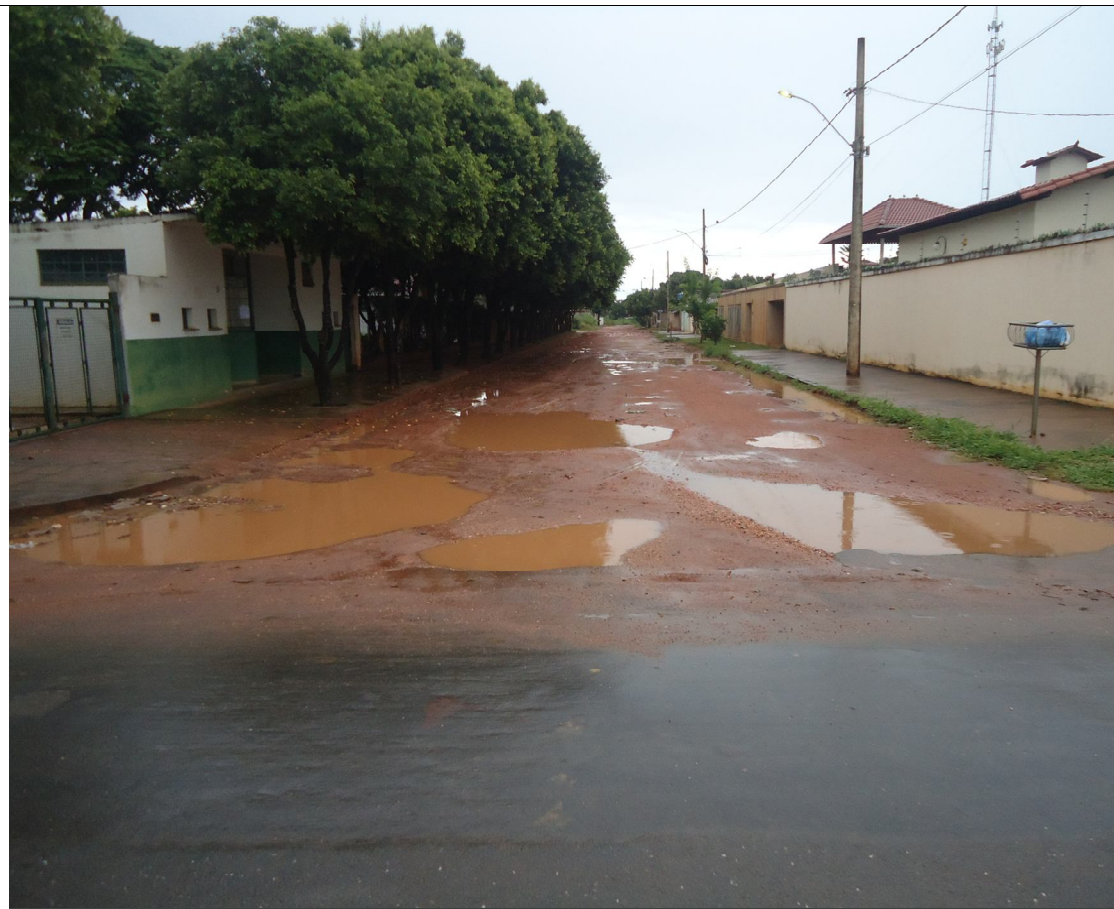
Foto 5: Tipo de obra: Pavimentação.
