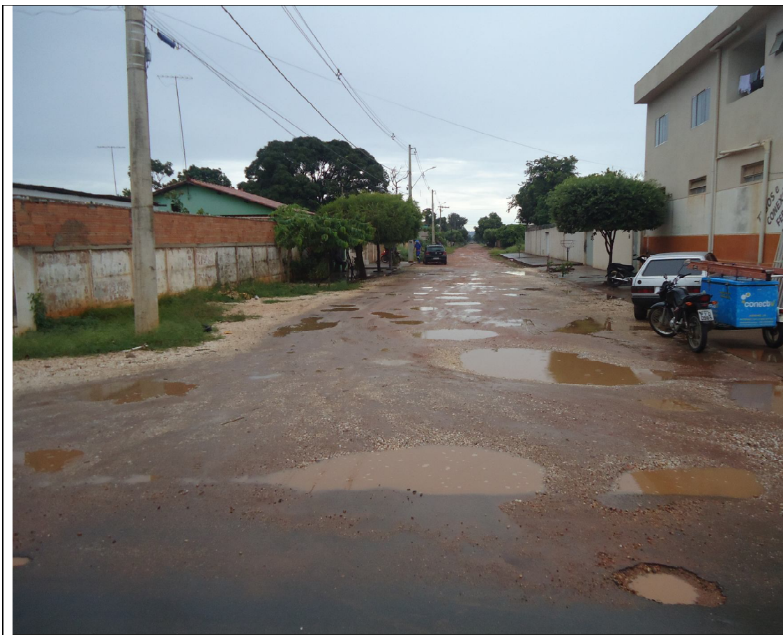
Foto 4: Tipo de obra: Pavimentação.
