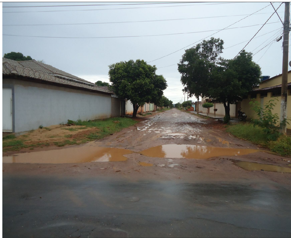
Foto 6: Tipo de obra: Pavimentação.
