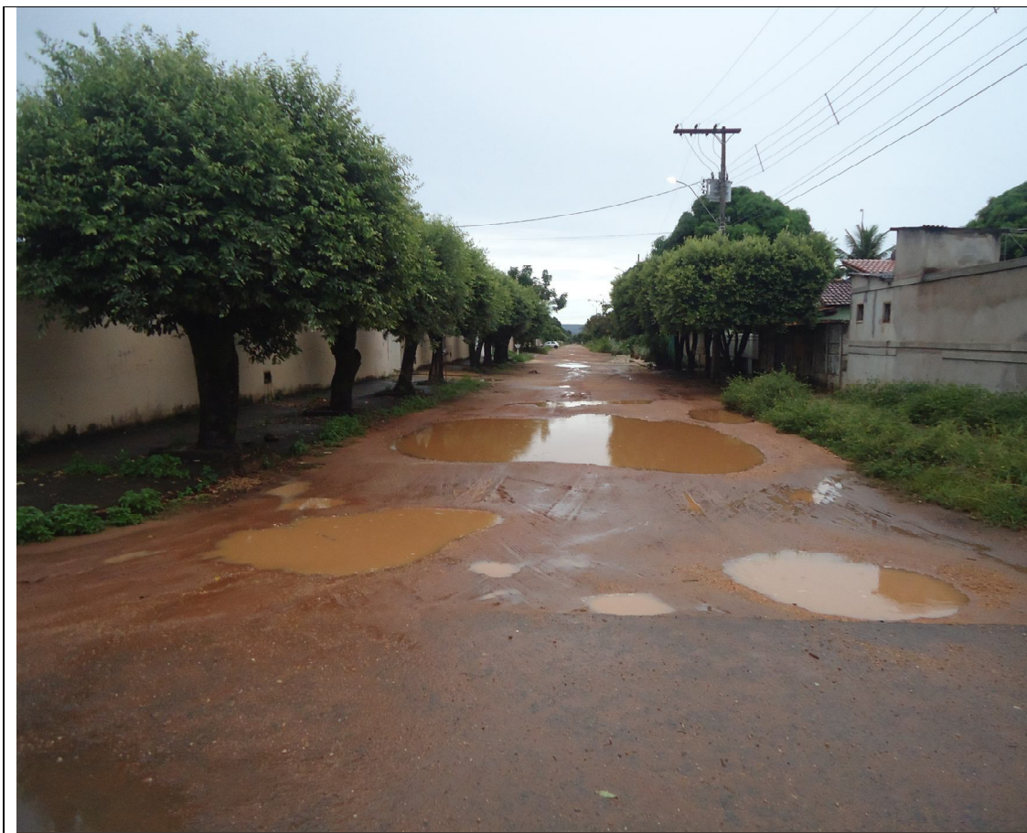
Foto 7: Tipo de obra: Pavimentação.
