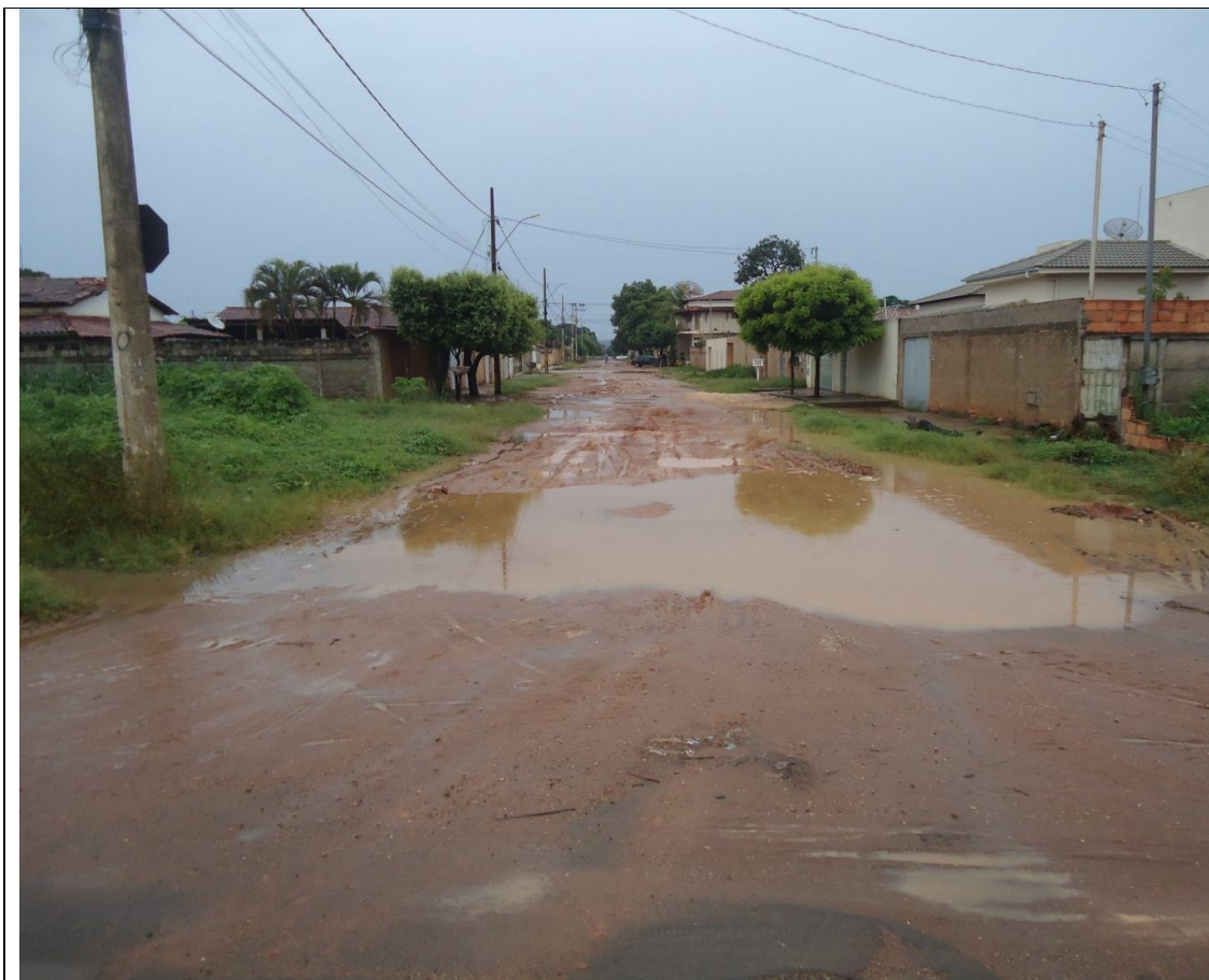
Foto 2: Tipo de obra: Pavimentação.
